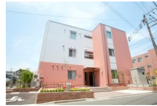
サービス付き高齢者向け住宅 ユノトレメゾンさがみ
